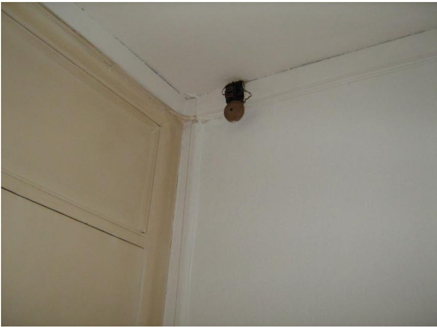
Renovering af rygerlejlighed i 2009
